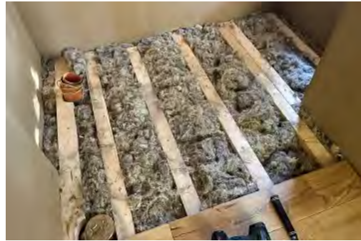
Hanfdämmung wurde im Bodenaufbau verwendet.
