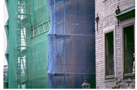
Weiche textile Gerüstverkleidung im Kontrast zu hartem Mauerwerk
