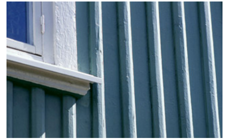
Fassadenausschnitt, Deckleistenschalung
