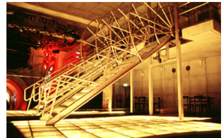
Tunneln: Schwenkbare Treppe
