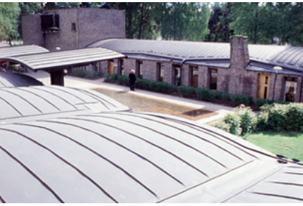
Blick aus dem OG über die Nebenraum-Dächer in den Innenhof
