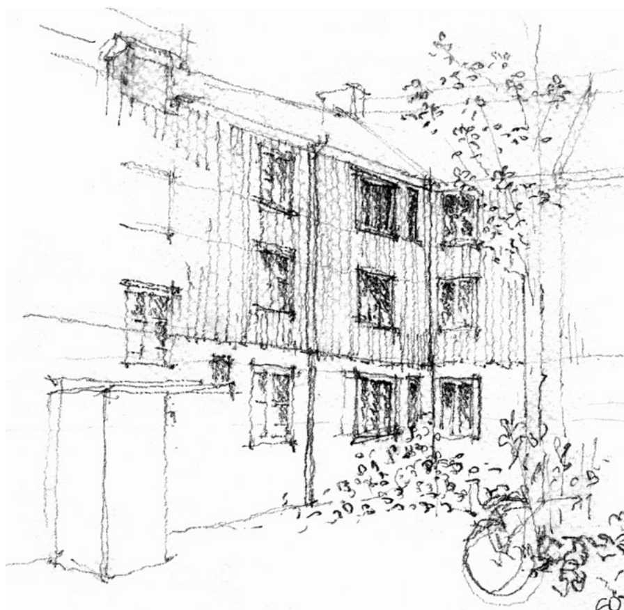
Typische Bauweise in Kungsladugård: EG in Stein, zwei Obergeschoße in Holz
