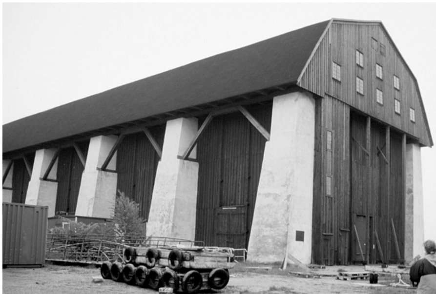
Vasaschuppen, Ansicht von Südwest
