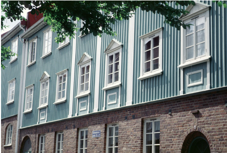
Die Bauweise des „Landhövdings“: Ein Geschoß in Stein, zwei darüber in Holz
