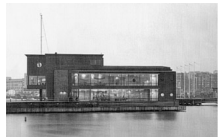
Restaurant „Västra Piren“, Ansicht
