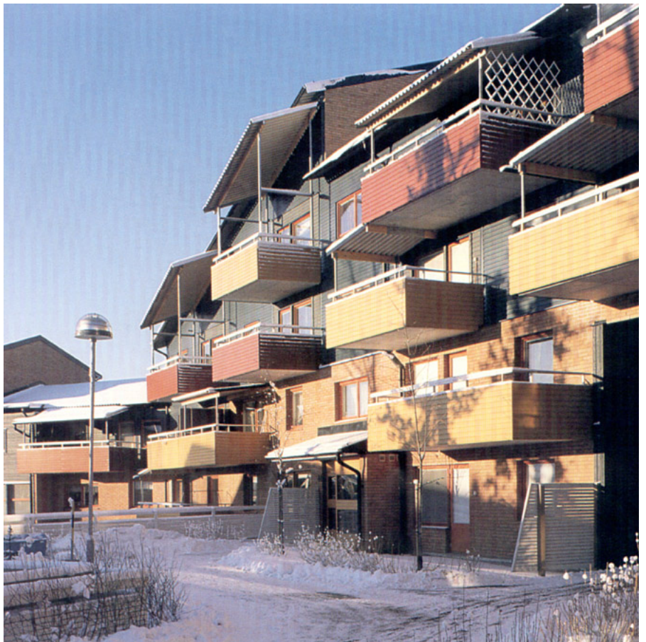
Ekerö: Fassadenelemente aus Sichtbeton
