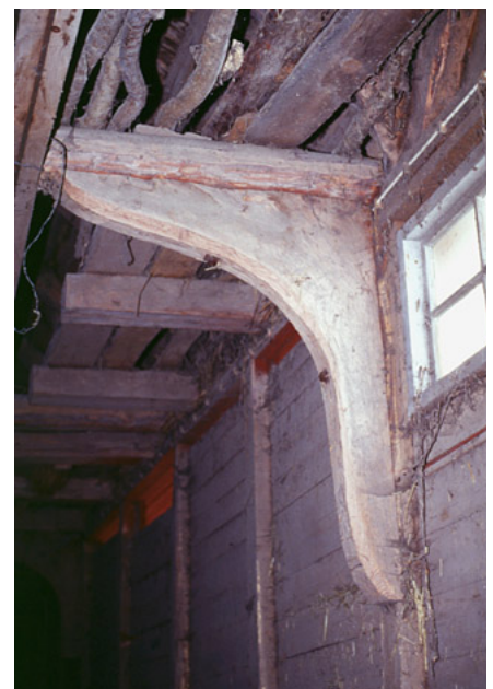
Detail aus dem Schiffsbau: Eckaussteifung mit Wurzelholz
