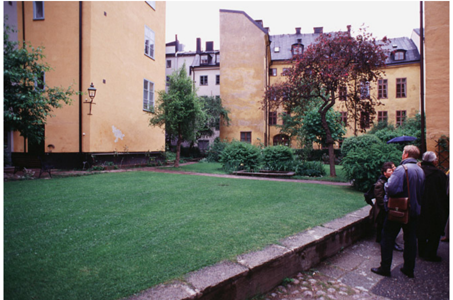
Innenhofsanierung im Quartier Cepheus
