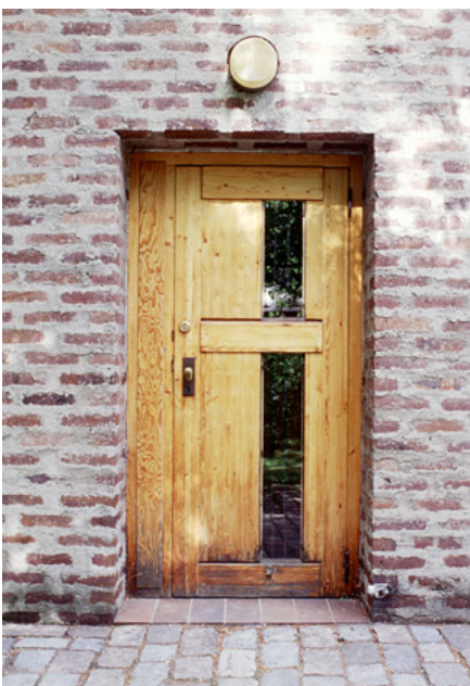
Türe eines Nebeneingangs
