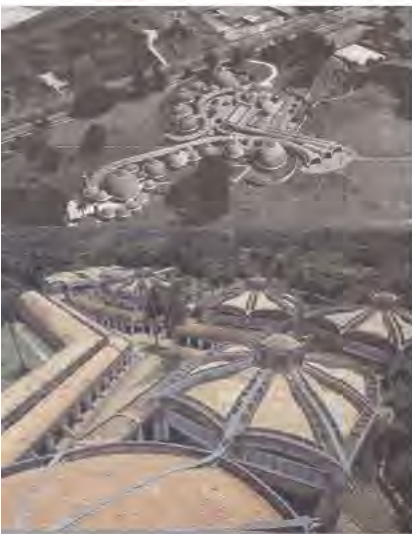
Las Escuelas Nacionales de Arte Cubanacán, R. Porro, 1961-1965
