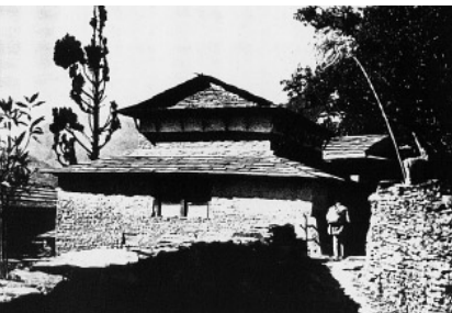
9: Schichtmauerwerk
