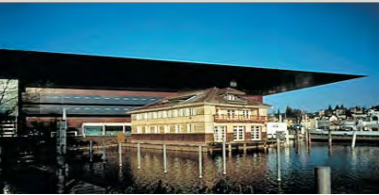
ostansicht vom seehaus
